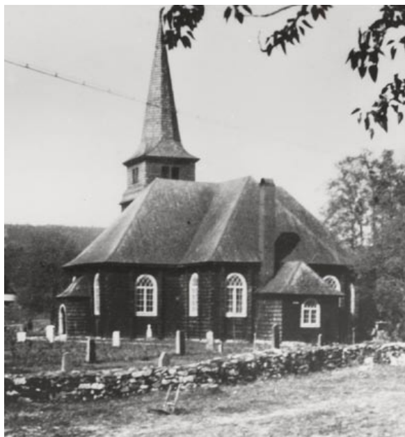
Östmarks kyrka före renoveringen. Den 2 juli 1935, på dagen 170 år efter kyrkans invigning, återinvigdes kyrkan efter en omfattande restaurering ledd av arkitekten Bror Almqvist. Vid denna restaurering ommålades bl. a. hela interiören, glasmålningar sattes in i de två fönstren i korsets östvägg och en ny altarpupsats, med den gamla altartavlan infogad, anskaffades. Källa: Östmarksportalen. Foto ur Yngve Fredsbergs samling.
